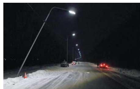
Рис. 4. ДТП с наездом на опору НО в ночное время с нарушением равномерности освещения
